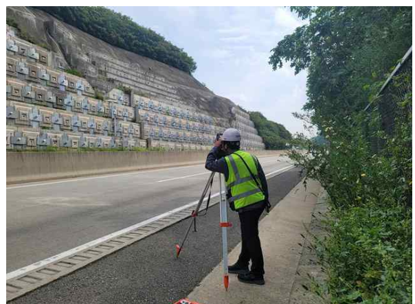
광파기를 이용한 경사도 측정
